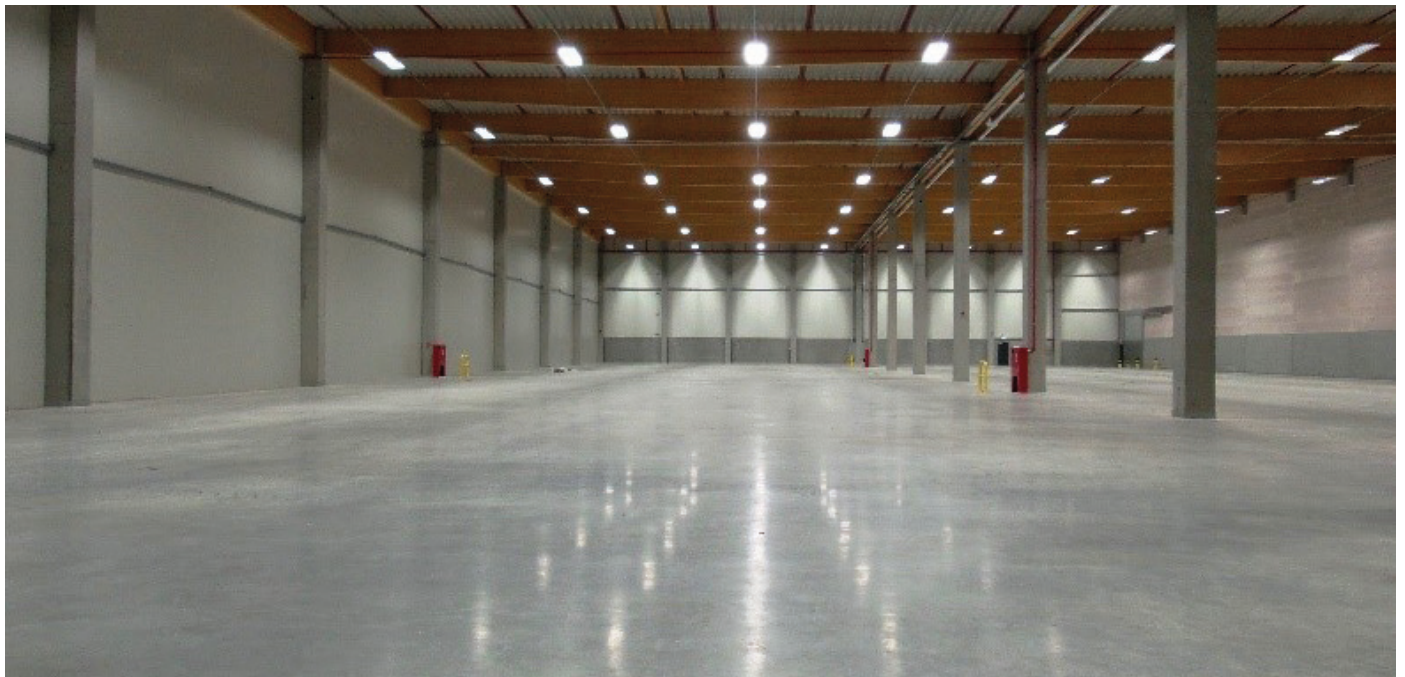
Figure 57. External storehouse area ("Halle Weiterstadt")
